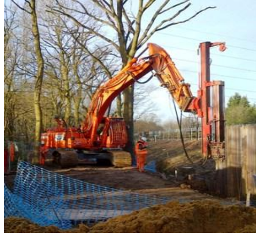
চিত্র-১১.১ : প্রি-কাস্ট পাইলের ভারবহন ক্ষমতা নির্ণয়
